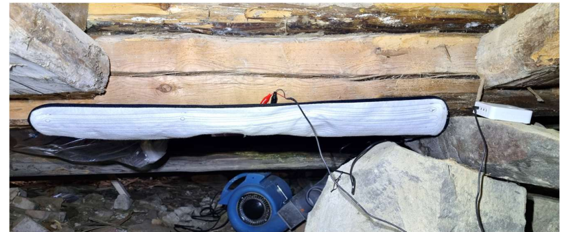
InfraVivo IR Torkfilt - fälttest Krypgrund
